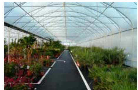
Tunnel à pieds droits 9,60m Hauteur standard sous support de culture 3,10m
