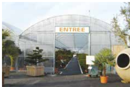
Tunnel à pieds droits 9,60m Hauteur standard sous support de culture 3,10m
